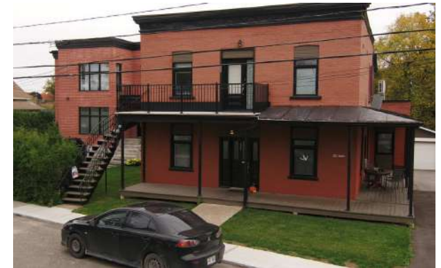
RÉNOVATION SOIGNÉE D'UN BÂTIMENT RÉSIDENTIEL. SOURCE : VILLE DE REPENTIGNY, 2022
