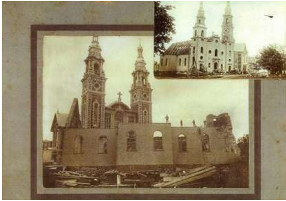
FIGURE 3 - CONSTRUCTION DE LA QUATRIÈME ÉGLISE (ARRIÈRE-PLAN) ET DÉMOLITION DE LA TROISIÈME (AVANT-PLAN)
