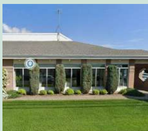
CENTRE DE SERVICES DES JARDINS 6276, RUE PRINCIPALE
