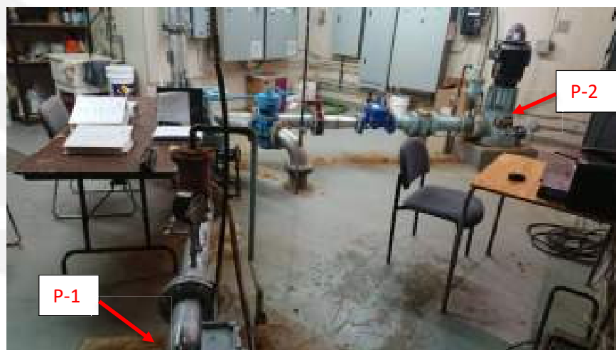
Vue du puits P-2 et de son environnement (27 août 2020)
