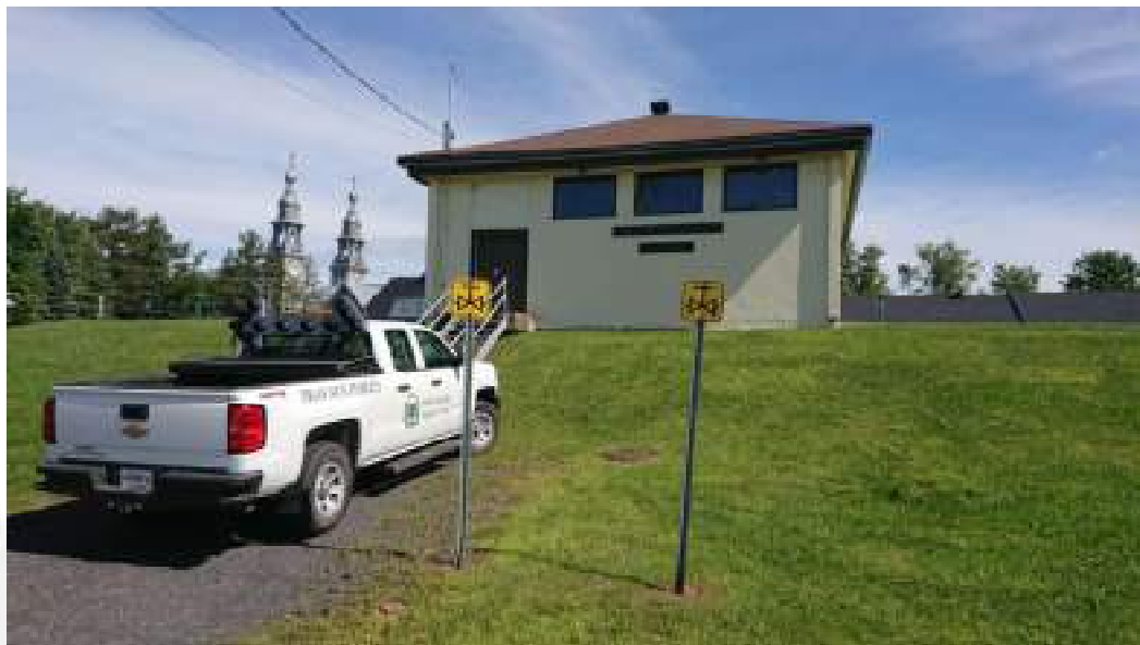
Figure 7 : Vue du réservoir d'emmagasinement de la municipalité de Sainte-Croix
