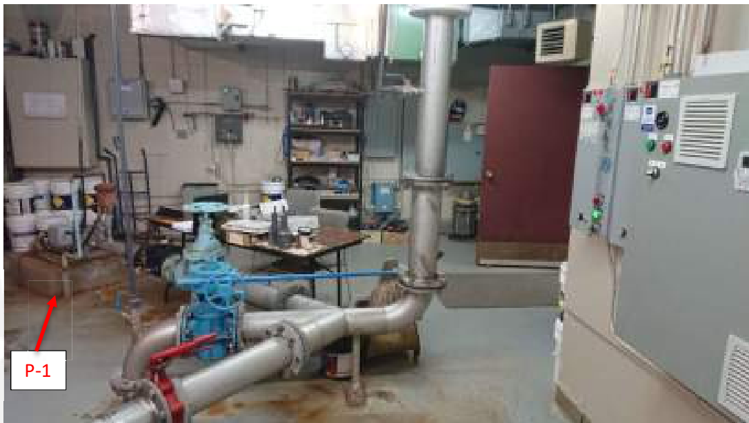
Vue de la tête du puits P-1 (27 août 2020).
