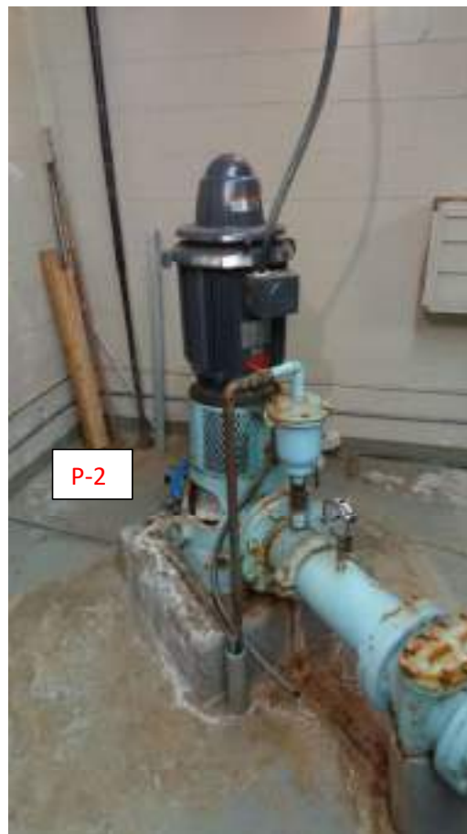
Vue de la tête du puits P-2 (27 août 2020)
