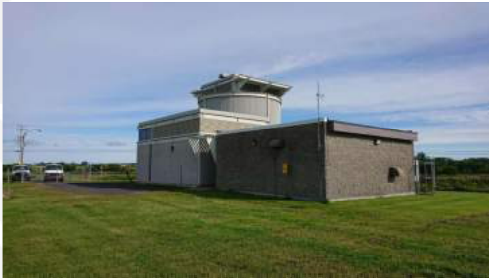
Vue arrière de la station de pompage/usine de traitement (27 août 2020)
