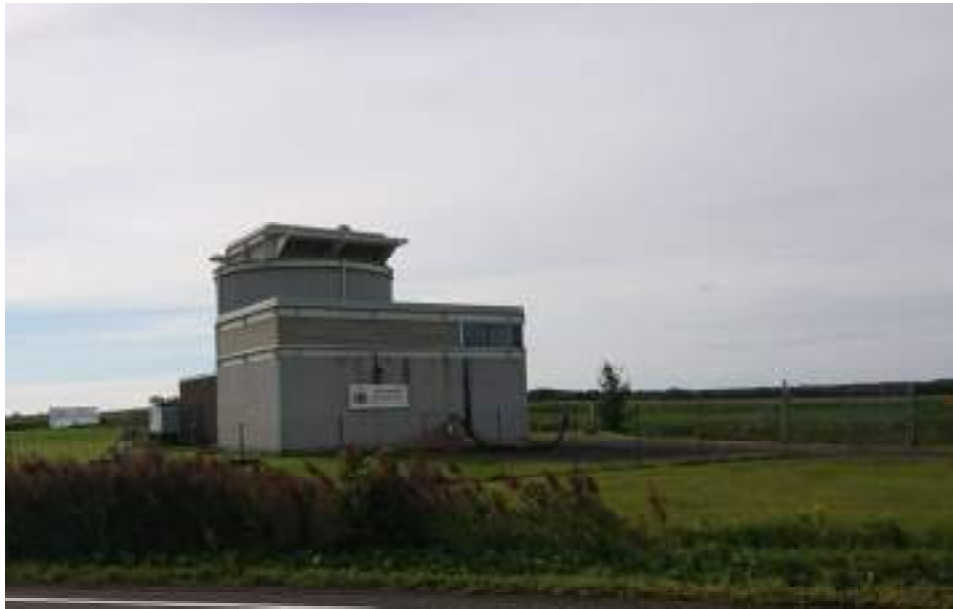
Vue avant de la station de pompage/usine de traitement des puits P-1 et P-2 (27 août 2020)
